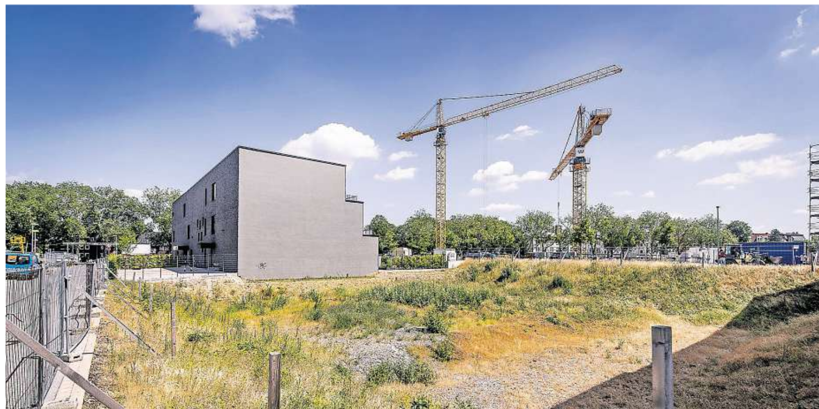
In die Baulücke zwischen Kita und Parkhaus soll bis Ende 2024 ein weiterer „Craftmen’s Place“ gebaut werden.
